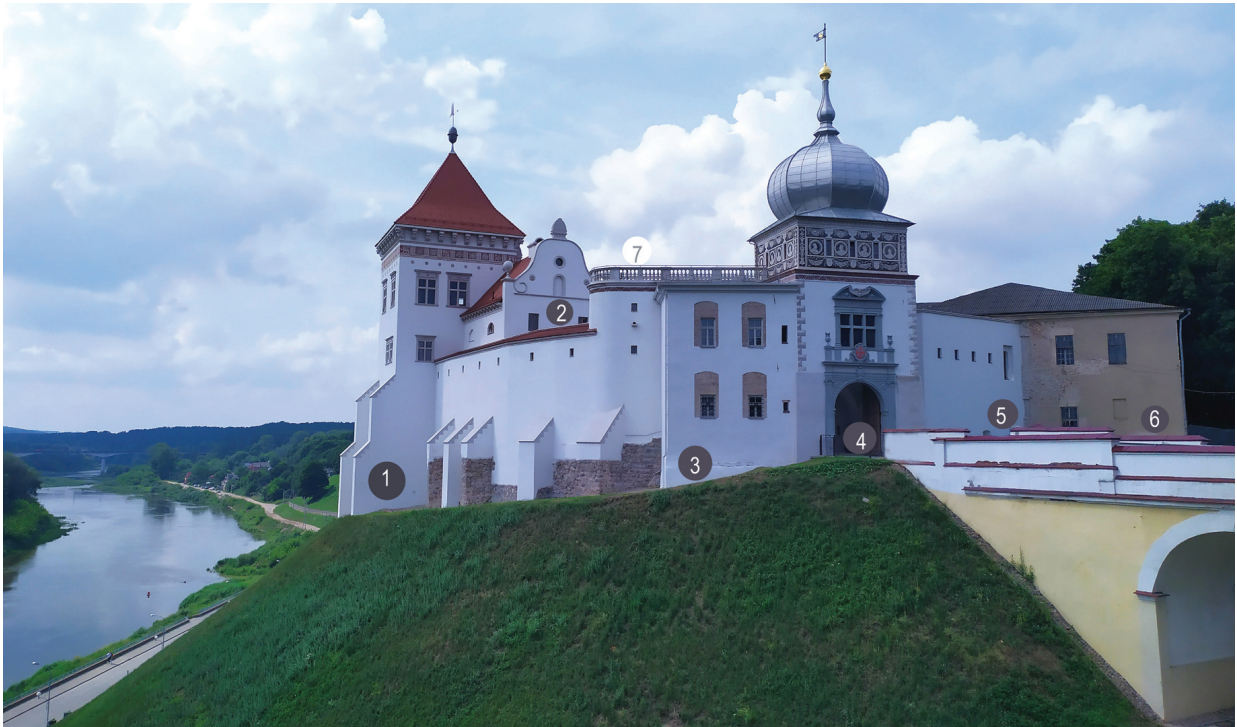
Рис. 1. Комплекс первой очереди реконструкции Старого замка в Гродно. Фото Н. А. Почобут, 2021 г. 1 — Средняя башня, 2 — «каменица», 3 — пристройка XVII в., 4 — воротная башня конца XVI в., 5 — барбакан, 6 — здание бывшего дворца конца XVI в., где располагалась до 2020 г. экспозиция ГГИАМ
